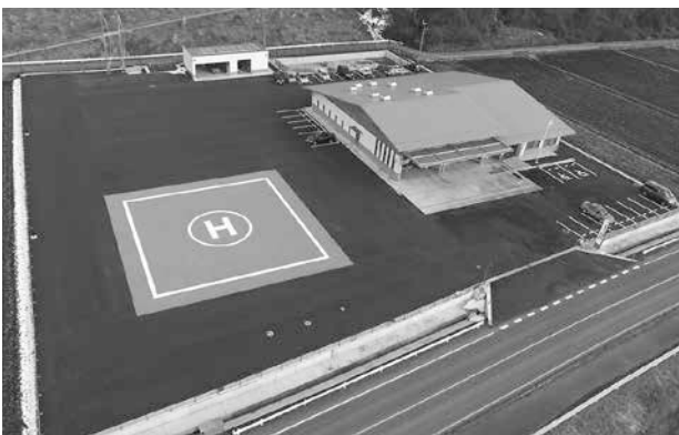
那珂川消防署全景
