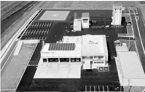
消防本部・那須烏山消防署全景
