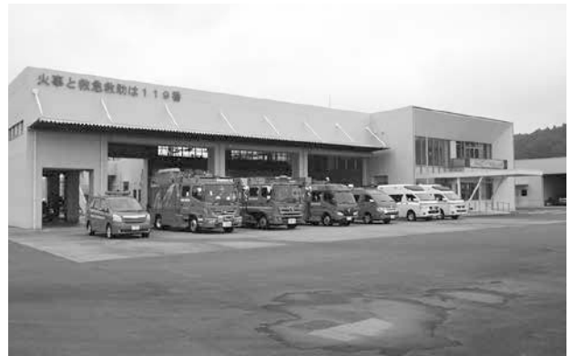
消防本部・那須烏山消防署
