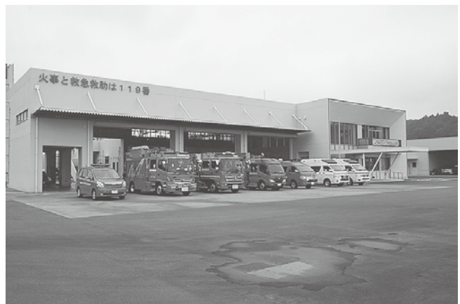
消防本部・那須烏山消防署
