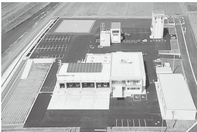
消防本部・那須烏山消防署全景
