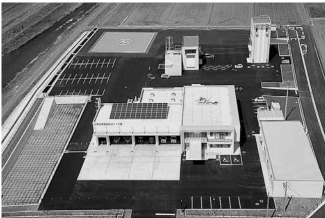
消防本部・那須烏山消防署全景
