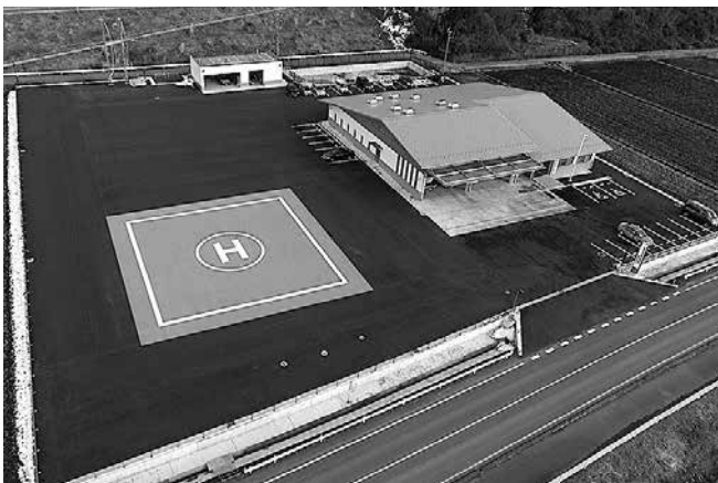
那珂川消防署全景
