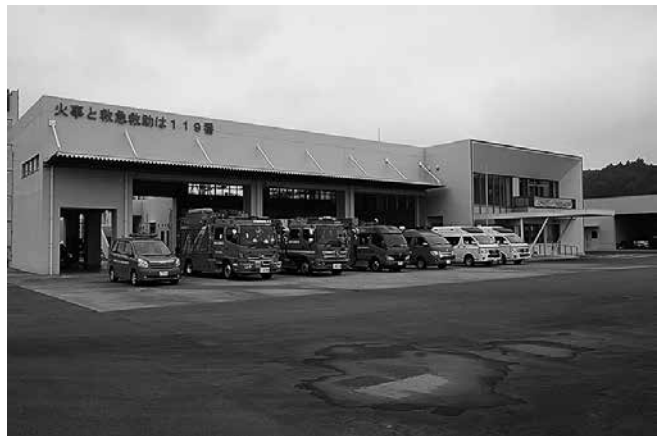
消防本部・那須烏山消防署
