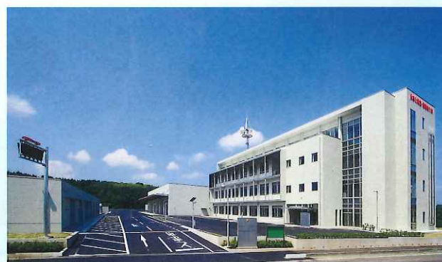
栃木北東地区消防指令センター 那須地区消防本部庁舎3階
