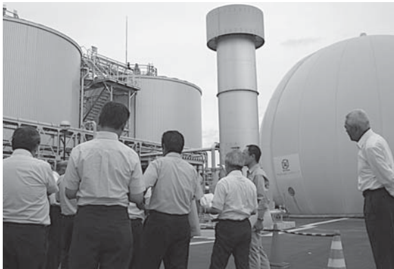
ガス発電施設を視察する参加者
